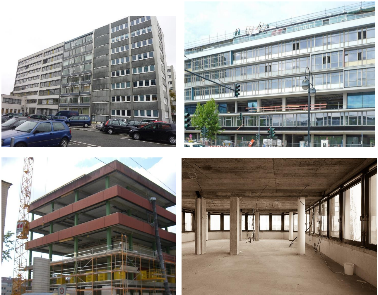
Abbildung 30: Typischer Skelettbau von Bürogebäuden
